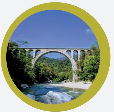
Pont des Abarines 6 : arrêt « Pont des Abarines »
